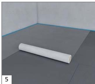
5 Appliquer sur toute la surface la bande d'armature en largeur 60 cm autocollante wedi *Tools* avec un recouvrement d'env. 5 cm. Dans les zones humides, pourvoir les percements et les jonctions entre les panneaux de construction de la bande d'étanchéité wedi *Tools*.
