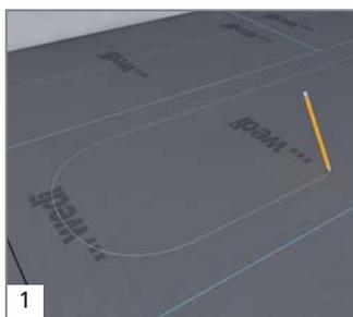
1 Dessiner les canaux/rainures pour l'installation du système de chauffage sur le panneau de construction wedi.
