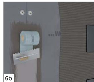
6b Pour la zone A0, les jonctions et percements peuvent alternativement être étanchés à l'aide de la bande d'étanchéité wedi *Tools* et de la colle à carrelage.
