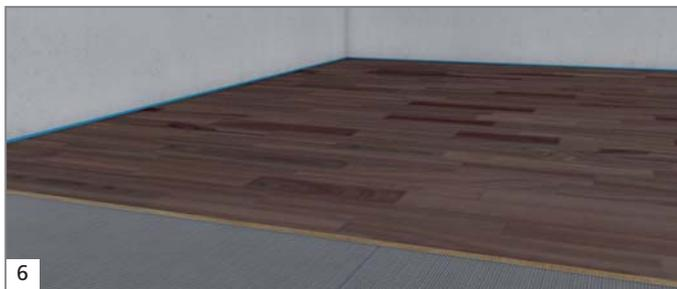
6 Il est également possible d'appliquer sur ce support un revêtement stratifié ou un parquet flottant prêt à poser. Pour le carrelage : dimensions des carreaux minimum 10 x 10 cm, épaisseur des carreaux minimum 7 mm.
