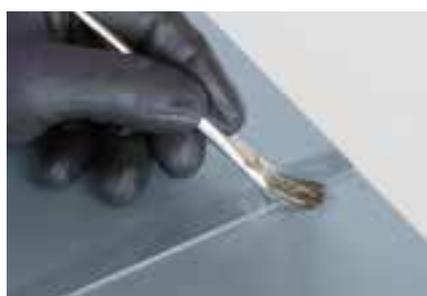
4. Appliquer du liquide à souder Z-04-S au niveau de la jonction à réaliser.
